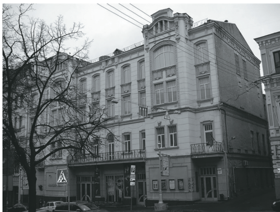
Будівля Молодого театру на Прорізній (сучасний вигляд).
